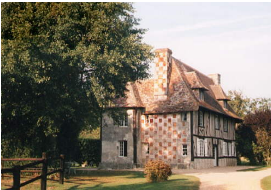
16e siècle : encorbellement marqué, premiers éléments de contreventement obliques
